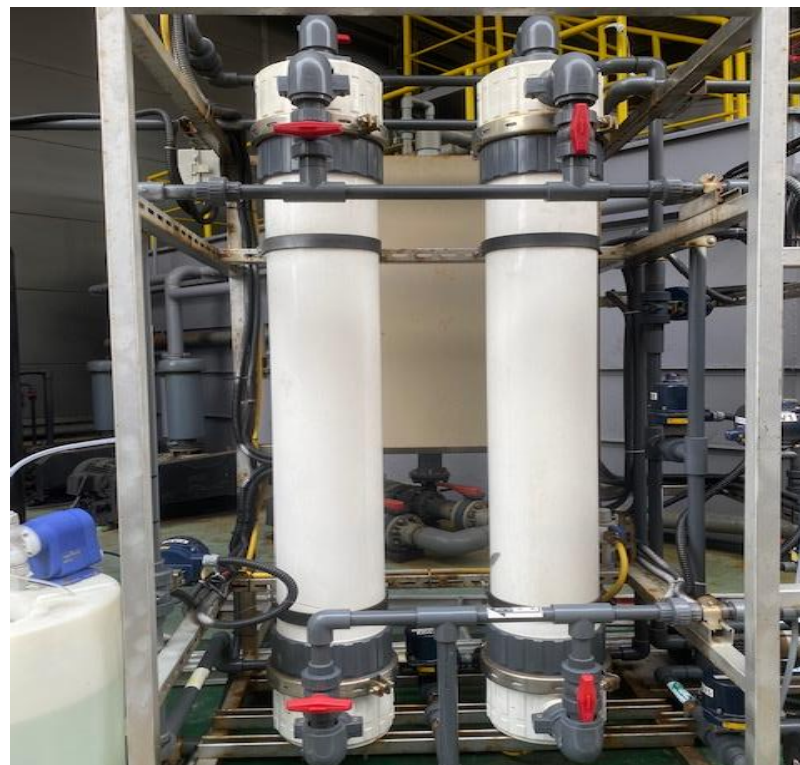
將切割廢水與其他廢水分流，導入UF系統 每年回收水量：12,775噸（佔總廢水量13%）
